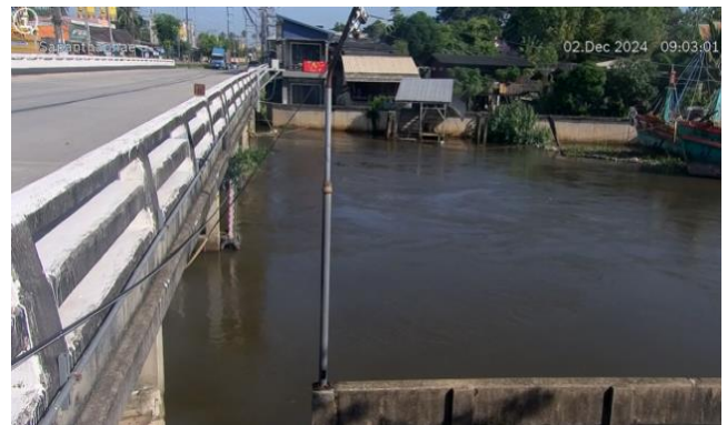
TC191911 : สะพานวัดท่าแพ ต.ปากพนون อ.เมือง จ.นครศรีธรรมราช
